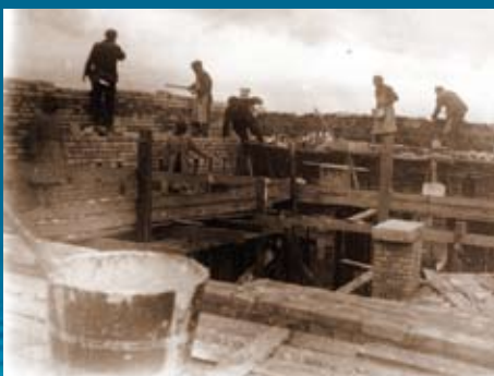
Строительство второго этажа ВНИРО (1933 г.)
