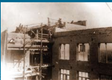
Строительство третьего этажа ВНИРО (1933 г.)
